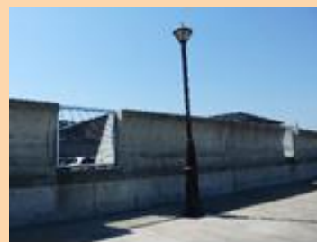
珍しい「窓つき堤防」があります
